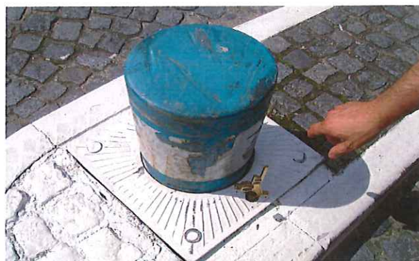
Borne escamotable et triangle de 15 mm
