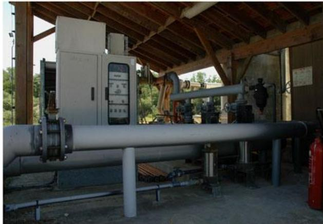
**Figure 42 – Photographie de l'installation géothermique de la ferme piscicole du Teich**
